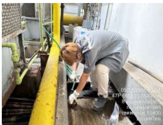
ท่อน้ำทิ้งจากหอผึ่งเย็นแต่ละเครื่อง
